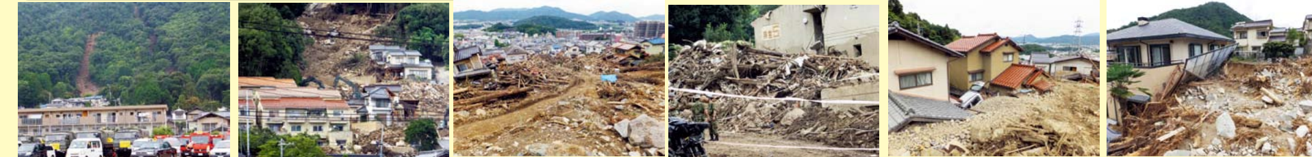
八木地区梅林小学校避難所。被災した緑井・八木地区の山裾は住宅団地で密集している。3階建の県営緑丘住宅も2階まで土砂で埋没。土石流の恐ろしさを実感。
