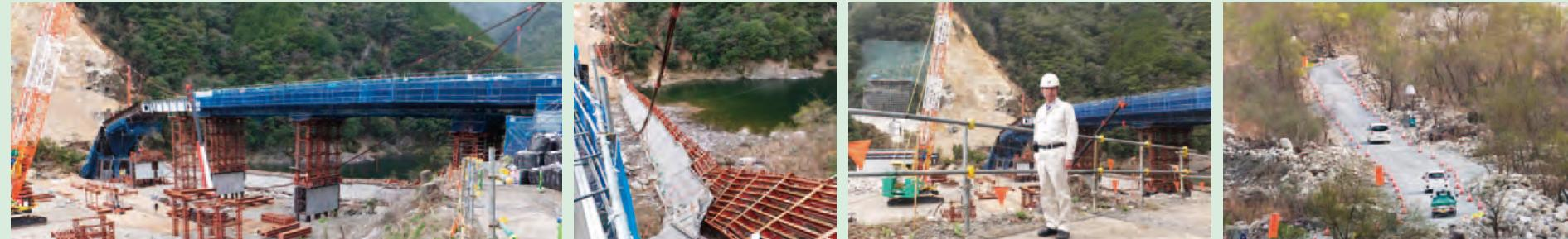
1/29周辺で落石を確認、断続的に通行止め。1/31、14:15小規模落石が頻繁で通行止め。17:08大規模土砂崩落、原田橋が落橋、監視中の職員2人が車ごと転落。崩落高さ約70m、幅約30m。3月21日は橋下で作業をしており、まだ時々小石が落下するため、橋上で2人が監視していた。仮設道路を通行する車は生活道の為、多い。
