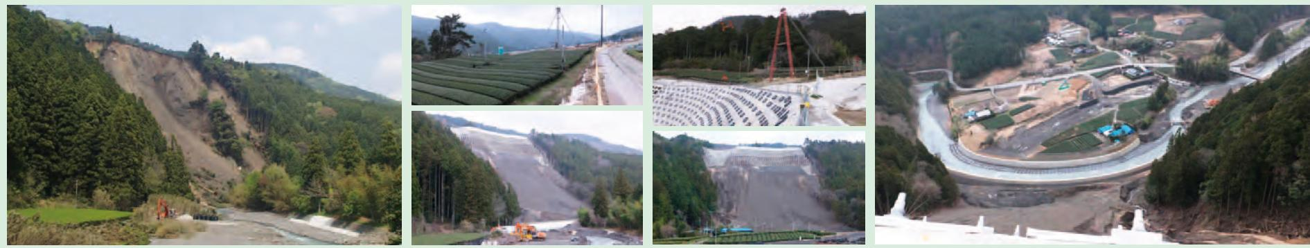
浜松から北東約40km、本川根に抜ける道路沿いに現場はあった。幅160m高さ150m深さ15mも崩壊していた。1級河川杉川の復旧は昨年11月に本川へ付替工事完了。
