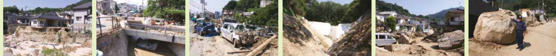
集中豪雨で山が崩れ、土砂で川が氾濫。流域は大きな被害。更に今年3月に完成した砂防ダムを大岩が乗り越え、矢野東団地内に転げ落ちて大惨事となった。
