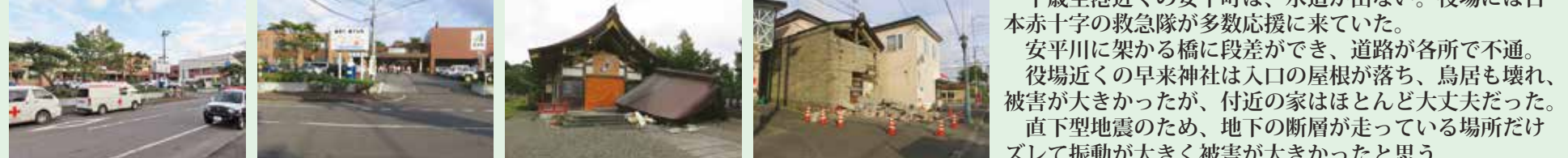
千歳空港近くの安平町は、水道が出ない。役場には日本赤十字の救急隊が多数応援に来ていた。安平川に架かる橋に段差ができ、道路が各所で不通。役場近くの早来神社は入口の屋根が落ち、鳥居も壊れ、被害が大きかったが、付近の家はほとんど大丈夫だった。直下型地震のため、地下の断層が走っている場所だけズレて振動が大きく被害が大きかったと思う。
