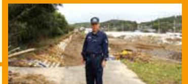
台風19号10月15日屋嶺茨木郡那珂川堤防決壊現場
