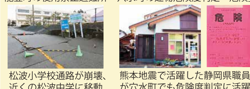
松波小学校通路が崩壊、近くの松波中学に移動 熊本地震で活躍した静岡県職員が穴水町でも危険度判定に活躍
