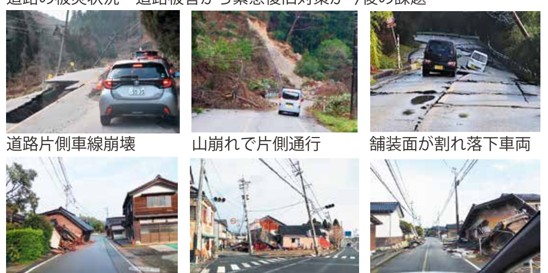
道路片側車線崩壊 山崩れで片側通行 舗装面が割れ落下車両
